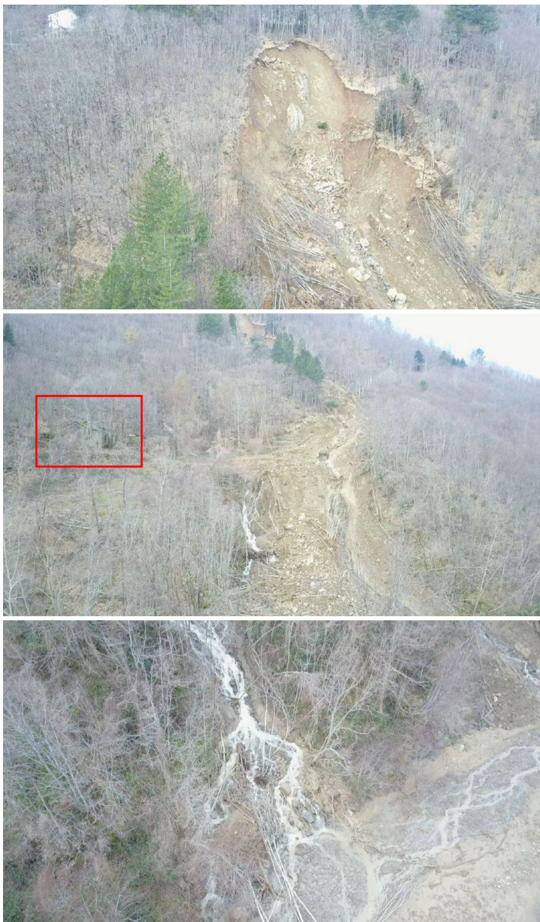
Figura 6 – Riprese della frana di Pian dei Sisi effettuate da drone la mattina del 20 febbraio 2018. In alto la zona di alimentazione; nel mezzo la zona di scorrimento (si vede il rudere Casa Giardino sulla destra della frana nel riquadro rosso); in basso l'arrivo del materiale nell'alveo del Torrente Lima.
