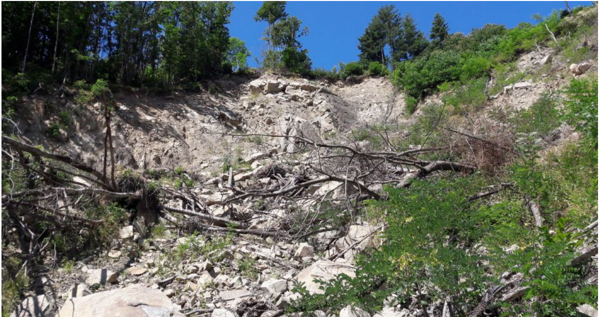
Figura 3 – Zona di alimentazione della frana con affioramento del piano di faglia, dislocato da un secondo sistema di fratture. Si riconosce un assetto a franapoggio degli strati. Si evidenzia la presenza di materiale mobilizzato sul versante all'interno del perimetro di frana. L'immagine è stata scattata il 17 luglio 2019.
